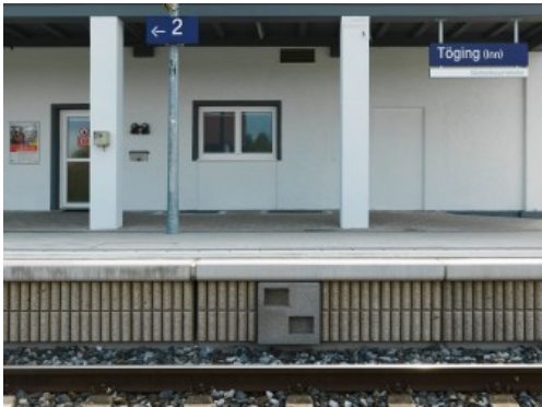
Hochabsorbierende Bahnsteigkante in Töging am Inn
