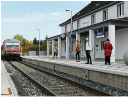
Hochabsorbierende Bahnsteigkante in Töging am Inn
