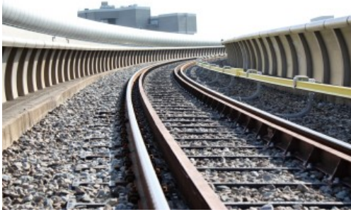
KLP® Hybrid-Kunststoffschwellen in Amsterdam
