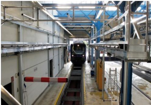
Einfahrt des Zuges; Podest mit Rammschutz eingefahren, zusätzlicher visueller Distanzstop
